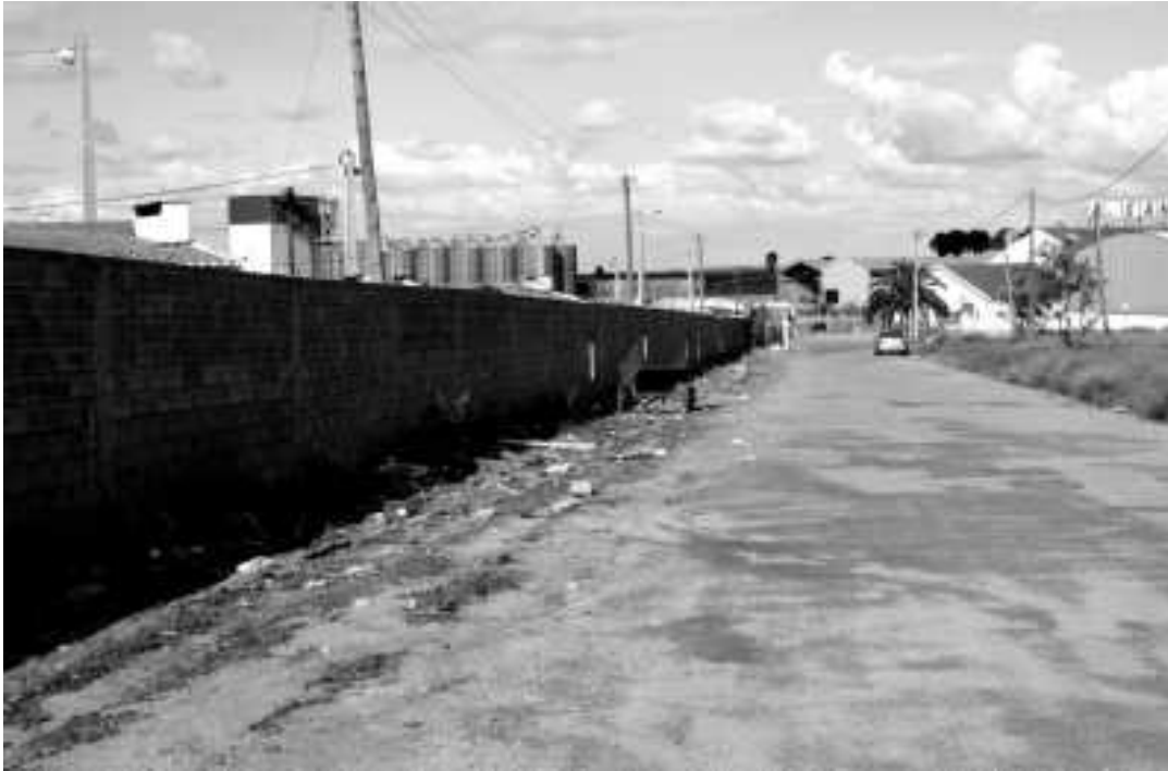
Figure 2: The wall of Bairro das Pedreiras in Beja.
